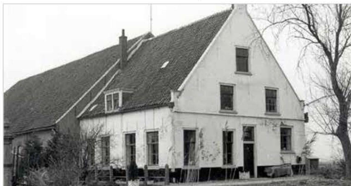
Zeldenrust (18e eeuw), Groeneweg 2, Den Bommel. Dit monument wordt ernstig bedreigd, de schuur is al jaren geleden afgebroken.
